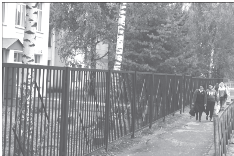
Новое ограждение территории школы №12
